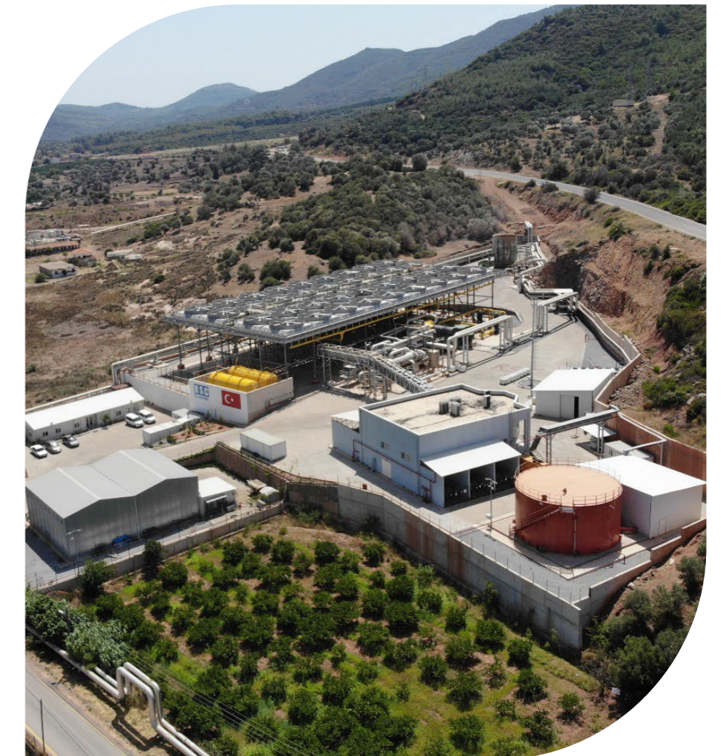
RSC Elektrik / İzmir
